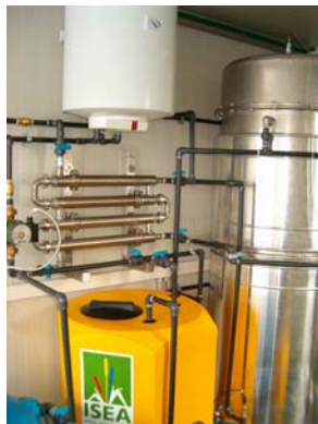
Prototipo a scala pilota dell' Impianto di depurazione effluenti da cantine vinicole
