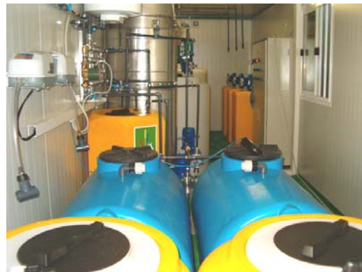
Prototipo a scala pilota dell' Impianto di depurazione effluenti da cantine vinicole
