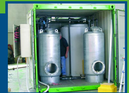
Impianto containerizzato trattamento reflui - 50 m 3 /d Campo di perforazione
